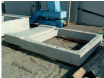
Prekast beton asansör boşluğunun birden fazla aşamada şantiyeye taşınması
