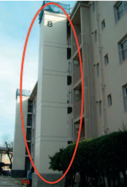
Asansör boşlukları binanın dışına monte edilebilmektedir.
