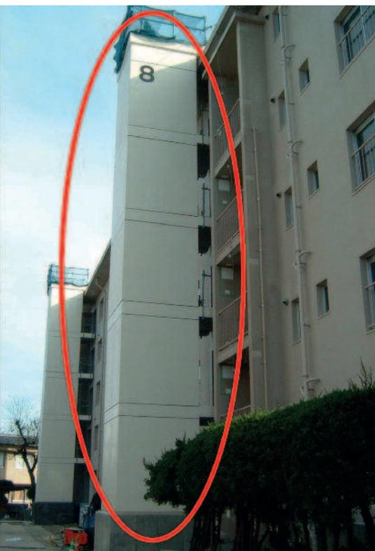
Os poços de elevadores podem ser instalados fora do edifício
