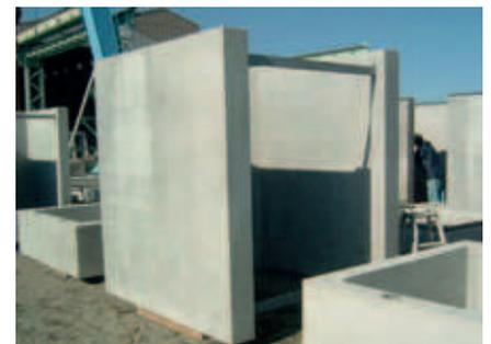
Trasporto della tromba dell'ascensore con prefabbricati al cantiere in diverse sezioni
