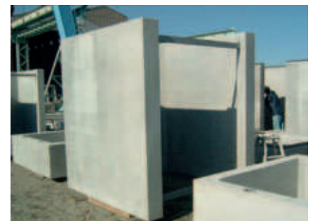
Transport des Betonfertigteilaufzugsschachts zur Baustelle in mehreren Abschnitten
