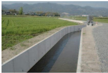
*A largura do canal da água pode ser ajustada com base na condição do local de construção. Estas imagens mostram que o Painel Seccional e o HI- P podem ser integrados ao meio ambiente*
