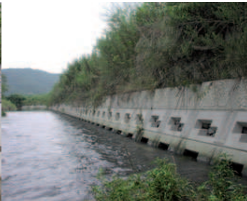
Şek. 2a, b, c: Örneğin blok taşları hem bent işlevi görmekte hem de çevre dostu bir geliştirme sağlamaktadır.
