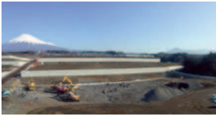
Şek. 3: Fuji Dağı'nın yakınındaki bir alanda Golcon Bloğu kullanılarak inşa edilen istinat duvarı
