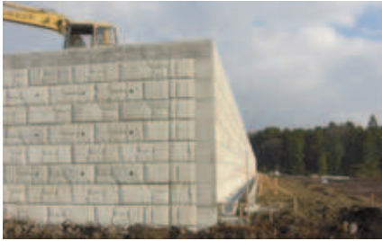
Şek. 2: Çok sayıda taştan oluşuyormuş görünümüne sahip Golcon Bloğu
