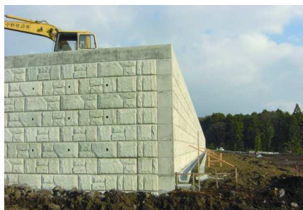
Рис. 2: Блоки Golcon с фактурной поверхностью
