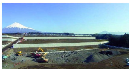
Рис. 3: Подпорные стенки из блоков Golcon на стройплощадке вблизи горы Фудзи
