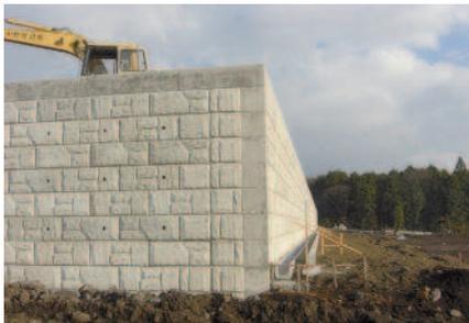
Fig. 2: Golcon Block com superfície desenhada
