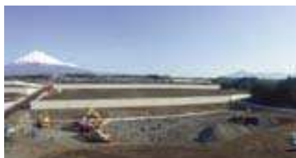
3: Golcon Block na placu budowy z widokiem na Fudzi.
