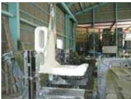
9: Wnętrze zakładu produkcyjnego z formą firmy Toyota. Rozformowywanie elementu muru oporowego (z lewej), otwarta forma (z prawej).
