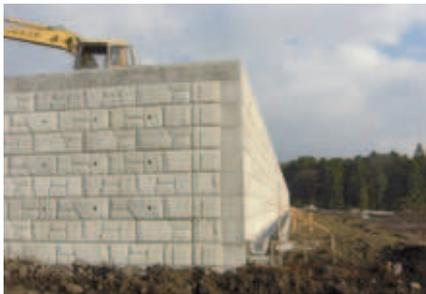
Fig. 2: blocchi Golcon con superficie personalizzata
