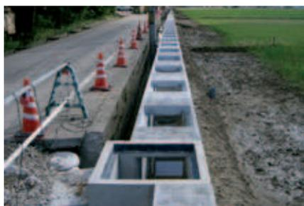
Fig. 3a: Drenaje colocado en una obra
