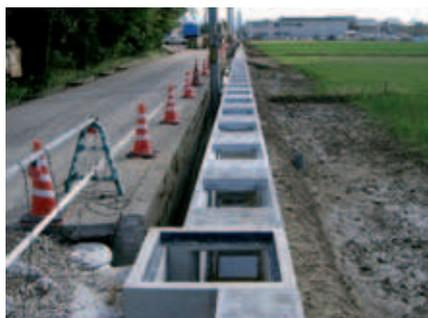
Abb. 3a: Eingebaute Drainage auf einer Baustelle
