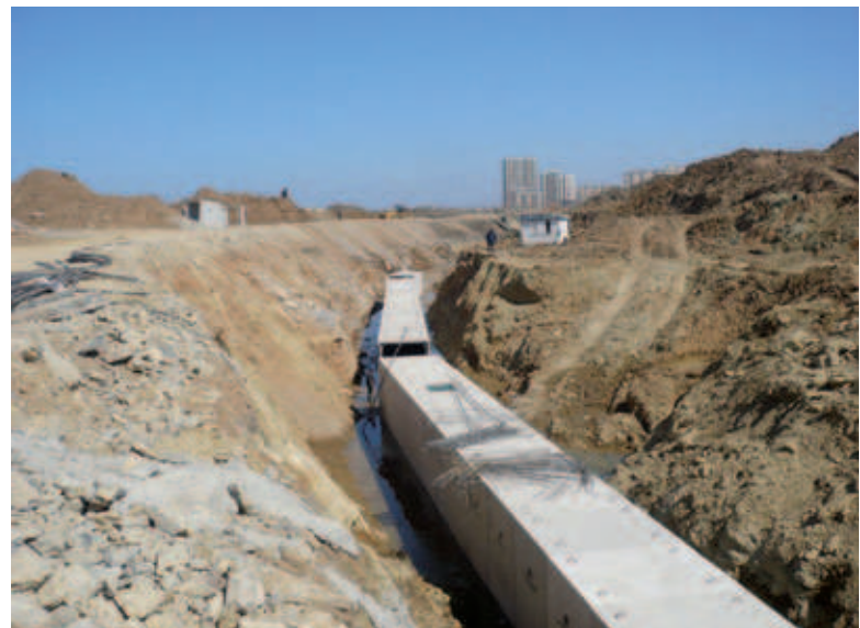
Şek. 8: Bir şantiyede, Toyotaforms'un ürettiği kalıplarla yapılan menfezler
