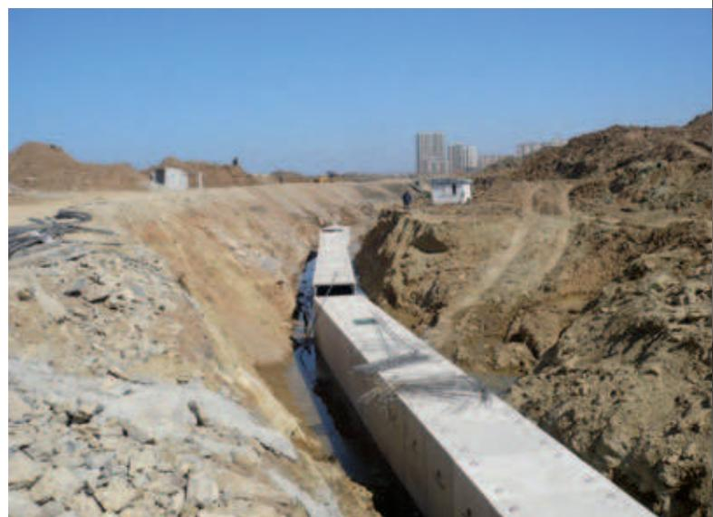
Fig. 8: Marcos prefabricados en una obra, fabricados con moldes de Toyotaforms
