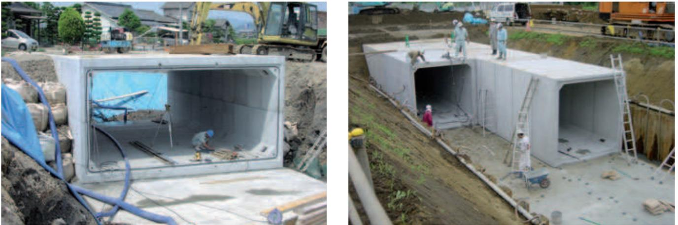
Fig. 1, 2: Marcos prefabricados en una obra
