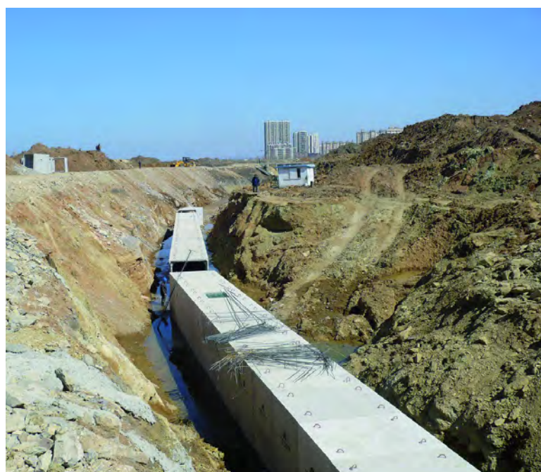
Рис. 8. Прямоугольные водопропускные трубы, произведенные с использованием форм Toyotaforms
