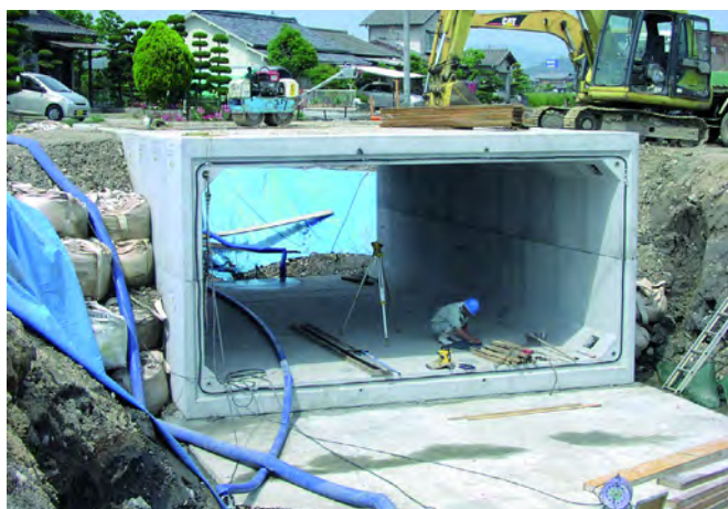
Рис. 1,2. Прямоугольные водопропускные трубы на стройке
