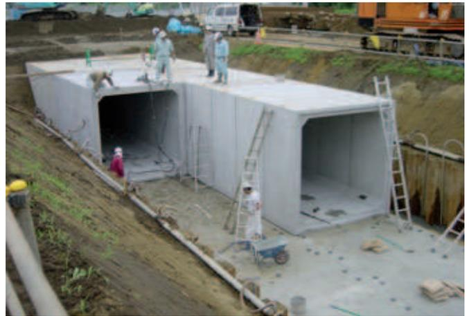
Fig. 1, 2: Passaggi rettangolari in cantiere
