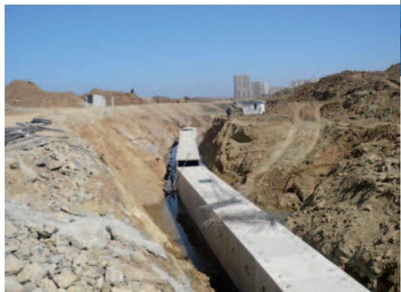
Fig. 8: Passaggi rettangolari in cantiere, realizzati con gli stampi di Toyotaforms
