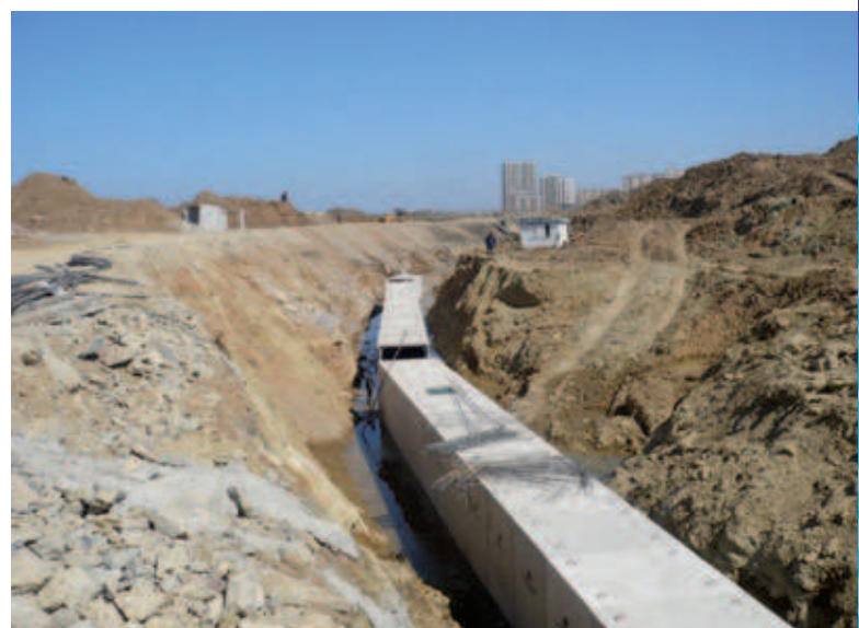
Abb. 8: Kastendurchlässe auf einer Baustelle, hergestellt mit Formen von Toyotaforms
