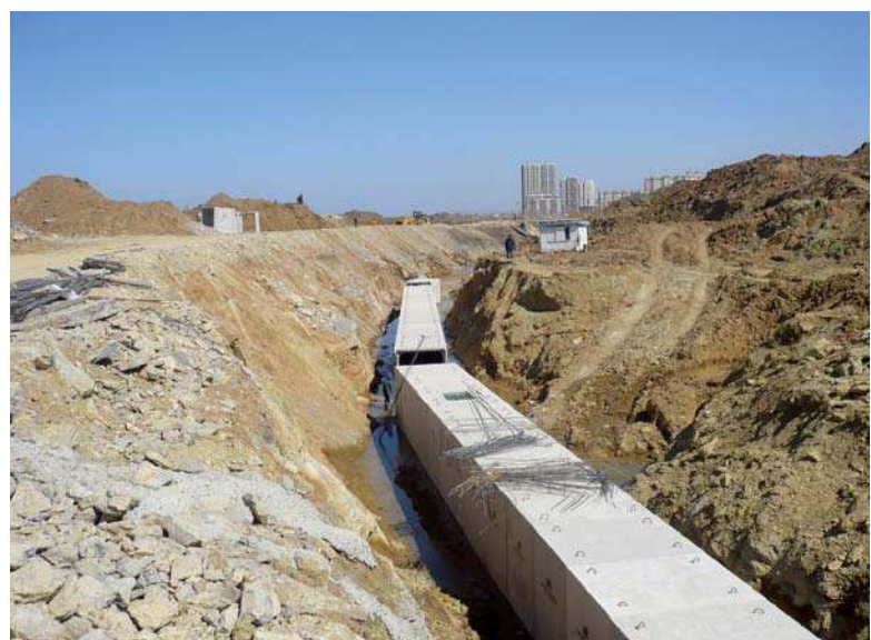
图 8: 施工现场由 Toyotaforms 生产的涵箱
