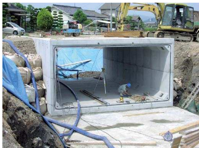
图 1、2: 施工现场的涵箱
