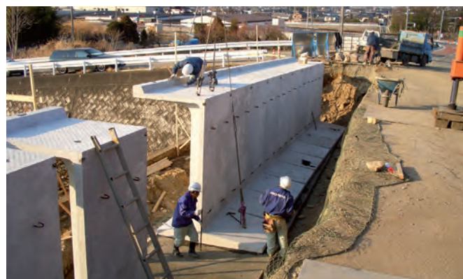
Рис. 3, Рис. 4: „Road L“ на стройплощадке и дорога, которую удалось расширить с помощью данного элемента
