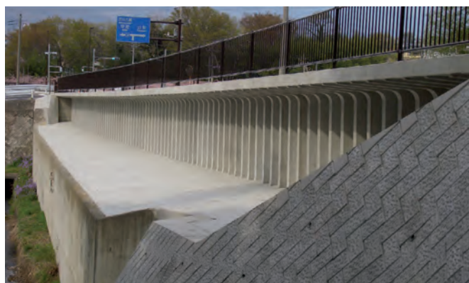
Рис. 3, Рис. 4: „Road L“ на стройплощадке и дорога, которую удалось расширить с помощью данного элемента
