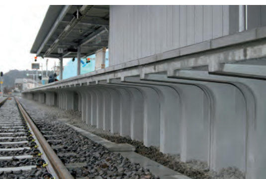
Рис. 5: „Road L” в больших масштабах используется в Японии при строительстве пассажирских платформ
