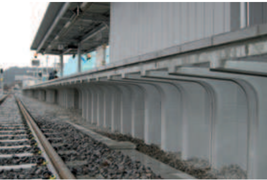
Abb. 5: „Road L“ wird in Japan beim Bahnsteigbau in großen Stückzahlen verwendet
