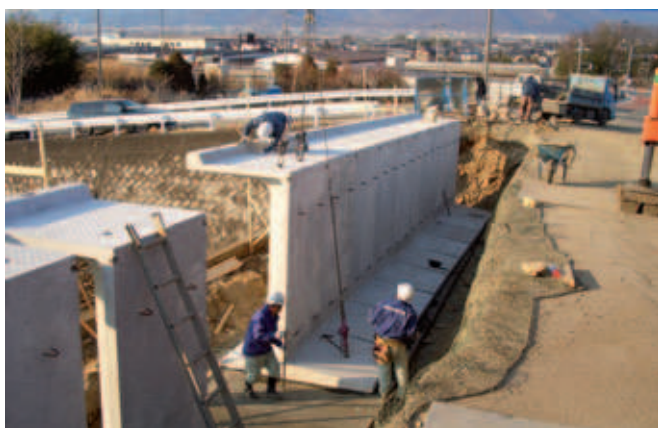
Abb. 3, Abb. 4: „Road L“ auf der Baustelle und eine damit verbreiterte Straße
