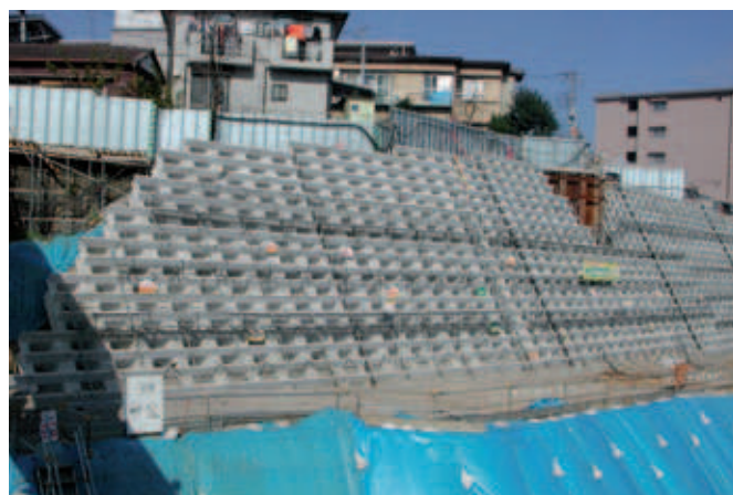
«Ландшафтные подпорные стенки» в процессе строительства
