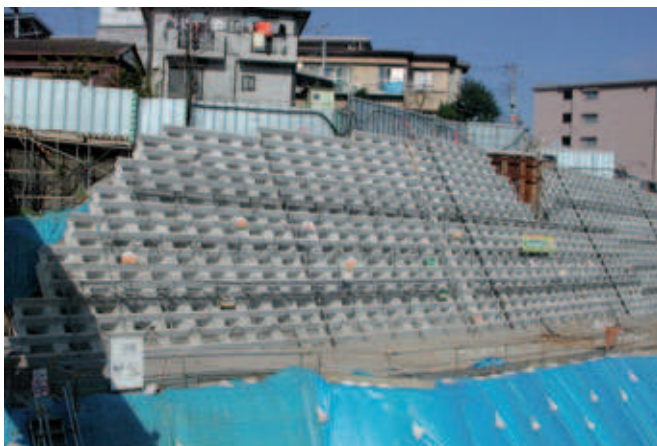
„Grüne Stützmauer“ im Bau
