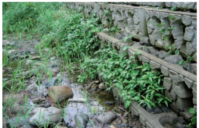
Fig. 1a, 1b: Blocos alveolares de concreto - usados principalmente para contenção de rios
