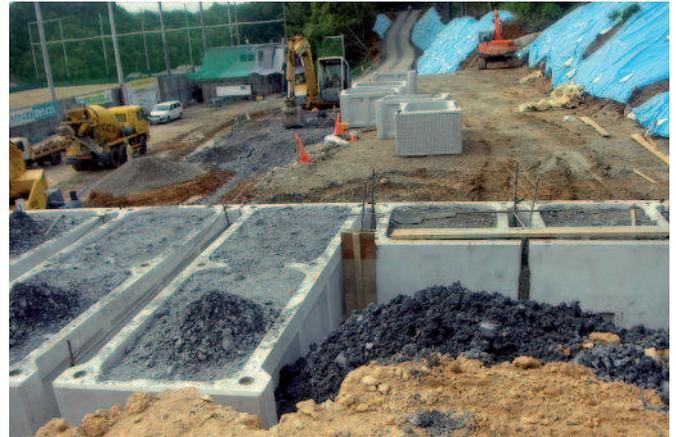
Fig. 2a, 2b: Blocos pré-moldados em formato de caixa
