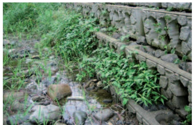
Fig. 1a, 1b: Blocchi in calcestruzzo per il consolidamento di rive
