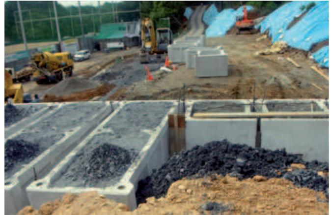
Abb. 2a, 2b: Kastenbetonsteine
