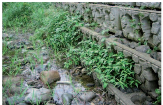
Abb. 1a, 1b: Betonsteine für Uferbefestigungen
