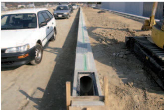
Fig. 3: Posa degli elementi di drenaggio
